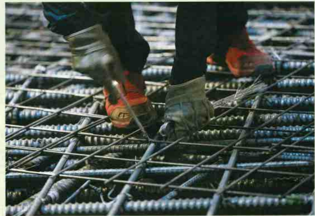
組まれた鉄筋を針金で手際よく固定していく。中腰で行う大変な作業だ
