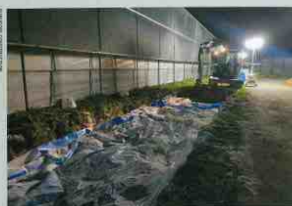
迅速な埋め立て作業は、地域の建設会社なくしてできない
