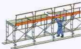
1層目作業床の取付け
