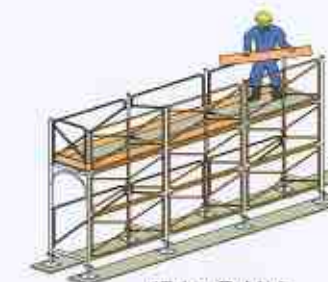
幅木の取付け
