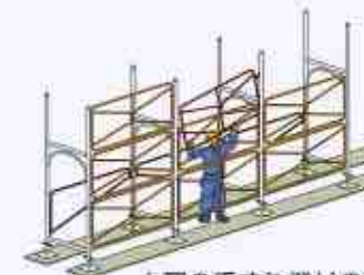
上層の手すり機材の取付け
