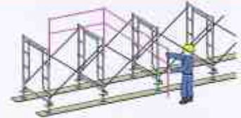
1層目先送り手すり機材の取付け
