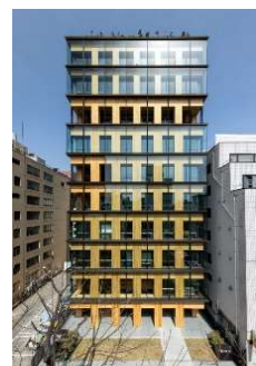
純木造 11階建て研修所
