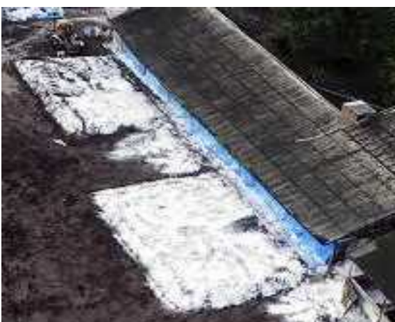
埋め戻し作業後（岐阜県建設業協会）
