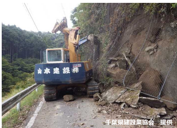
千葉県建設業協会 提供 千葉県建設業協会会員による道路啓開 (千葉県大多喜町)
