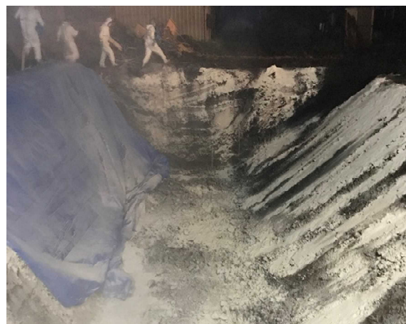
消石灰散布作業（岐阜県建設業協会）
