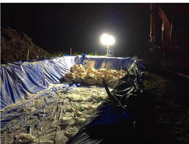
埋却溝への投入作業（岐阜県建設業協会）
