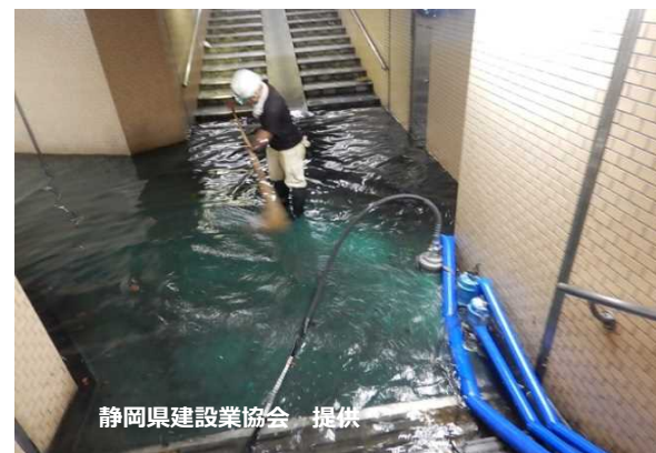
静岡県建設業協会 提供 静岡県建設業協会会員による地下道冠水排水作業 (静岡県焼津市)
