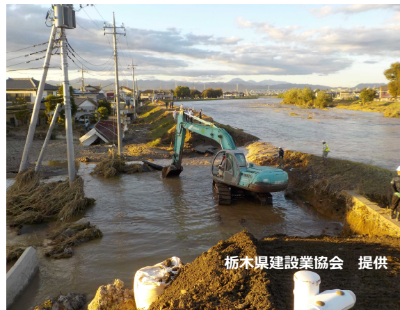
栃木県建設業協会 提供 栃木県建設業協会会員による河川堤防緊急応急 (栃木県佐野市)
