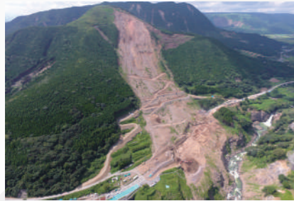
阿蘇大橋地区斜面防災対策工事
