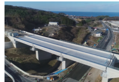
【特別賞】湖陵多伎道路多伎PC上部工事
