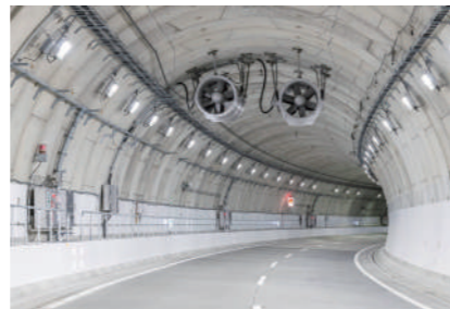
阪神高速道路大和川線シールドトンネル工事
