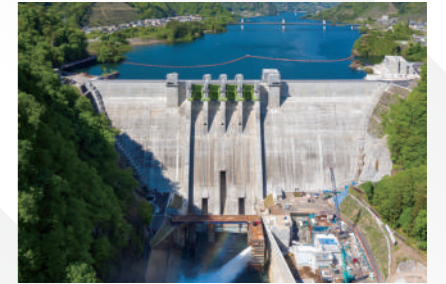
ハッ場ダム本体建設工事
