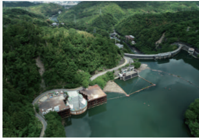
天ヶ瀬ダム再開発トンネル放流設備流入部建設工事
