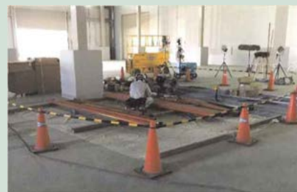
工事エリアの区画を設定して作業
