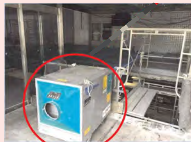
集塵機を設置し室内の換気を実施
