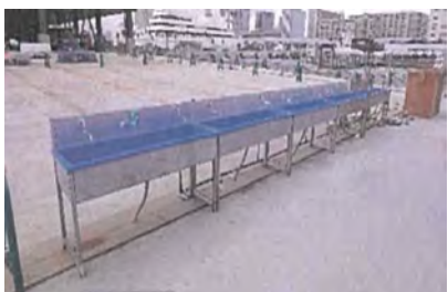
現場の手洗い場所の増設
