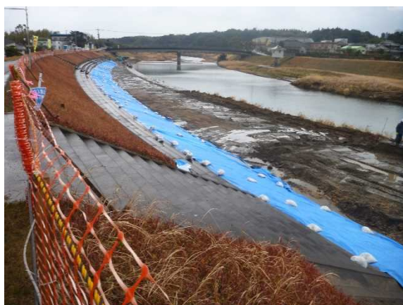
計測対象箇所(終点側)
