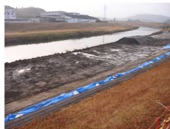
計測対象箇所(終点側)
