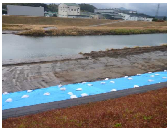
計測対象箇所(平場部)
