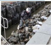
◆ 狭い足場での移動時に、脚ベルトが、手すりのクランプに引っかかる (バックシブ)
